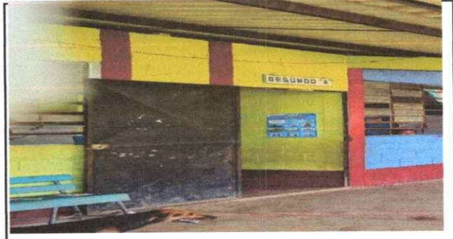
Foto 2: Cambio de puertas
