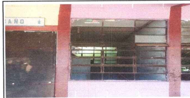
Foto 4: Cambio de 4 ventanas de baños
