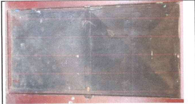
Foto1: Cambio de 7 puertas de 2.33 x 1 m
