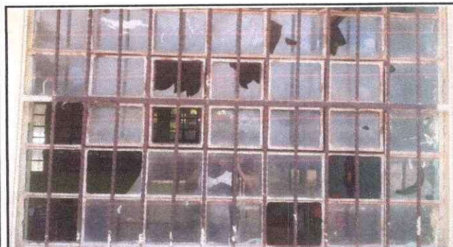
Foto 3: Pintura y cambio de vidrios de 26 ventanas
